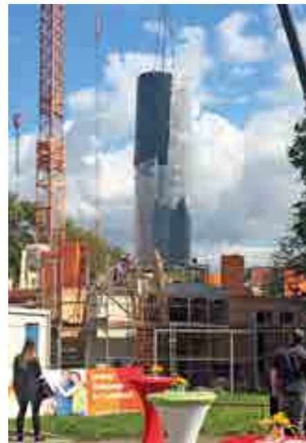
Mit dem Einbau des Wärmespeichers mit einem Fassungsvermögen von 25.000 l erhält das Gebäude sein „Herzstück“
