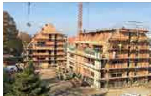
Wichtig für ein Sonnenhaus ist die hochwärmegeprägte Gebäudehülle. Beim Projekt in Cottbus wurden dazu mit Dämmstoff verfüllte Mauerziegel verwendet. Eine zusätzliche Außendämmung konnte dadurch entfallen
